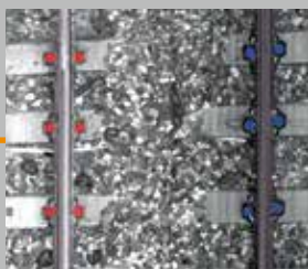
Inspection des attaches élastiques
