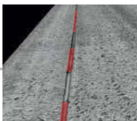
Joints de béton
